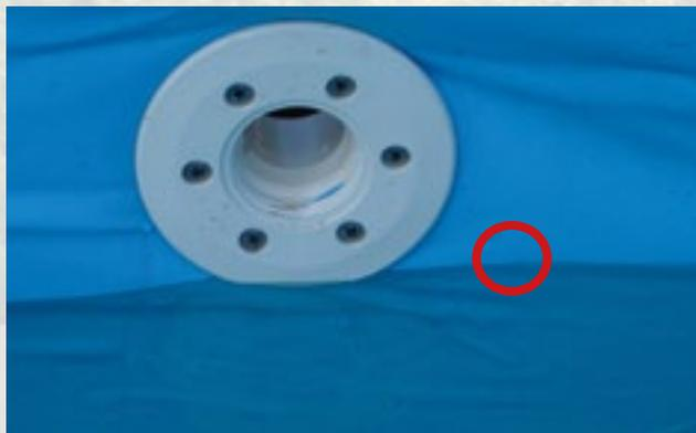
Hier erfolgten das Schneiden des Loches und die Montage der Einlaufdüse zu früh.
