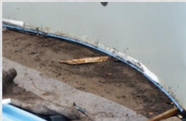
Bei diesem Pool war die Bodenschiene bereits nach einem Jahr an zwei Stellen abgesunken. An diesen Stellen schwappte dann das Poolwasser sehr schnell über, und es wurde immer schlimmer.
