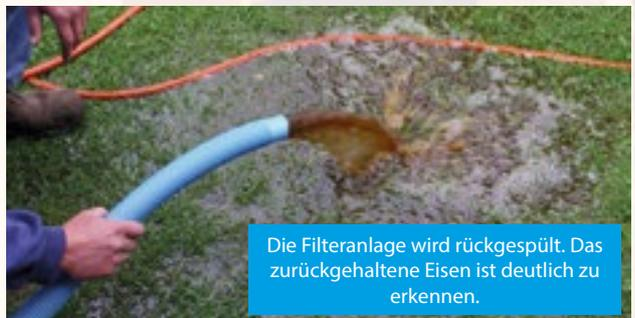
Die Filteranlage wird rückgespült. Das zurückgehaltene Eisen ist deutlich zu erkennen.
