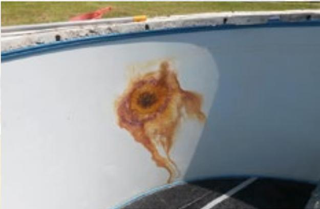
Durch ein kleines Löchlein lief hier Poolwasser zwischen Innenhülle und Stahlwand. Da hier der Korrosions-Schutz verletzt war, begann der Korrosions-Prozess.
