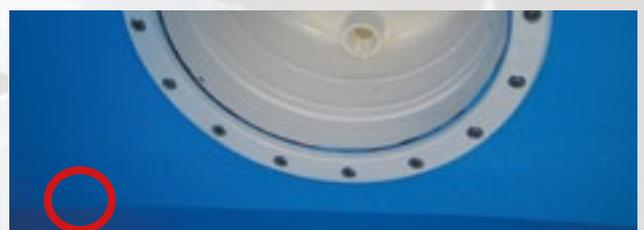
Erfolgt das Schneiden der Öffnungen vorher und die Einbauteile werden montiert, kommt es zur Falten-Bildung rund um die Einbauteile. Im schlimmsten Fall reißt die Innenhülle sogar.
