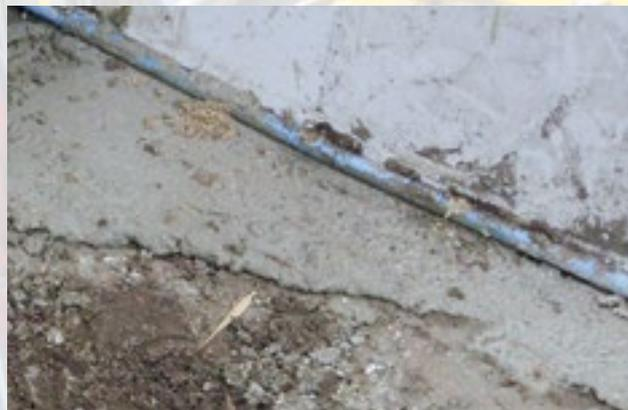
Der Besitzer dieses Pools hat als Notfall-Maßnahme das Wasser abgelassen, die Innenhülle ausgehängt und die Bodenschienen mit Beton unterfüttert.
