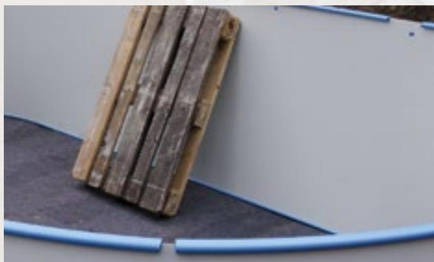
Warum ist dies notwendig? Hält sich ein Badender an der Seitenwand fest, so wird diese nach innen gezogen. Dadurch gelangen Schmutz und Steinen in den Zwischenraum zwischen Stahlwand und Stützwand. Die Stahlwand legt sich dann nie wieder gerade an die Stützwand an.
